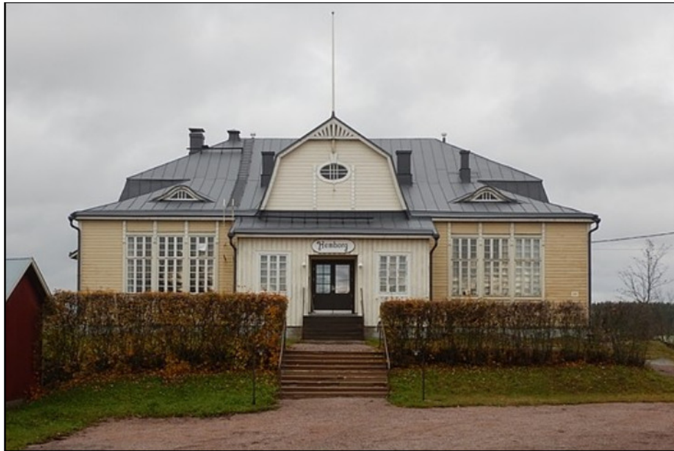
Det nymålade taket på Lokaaln
